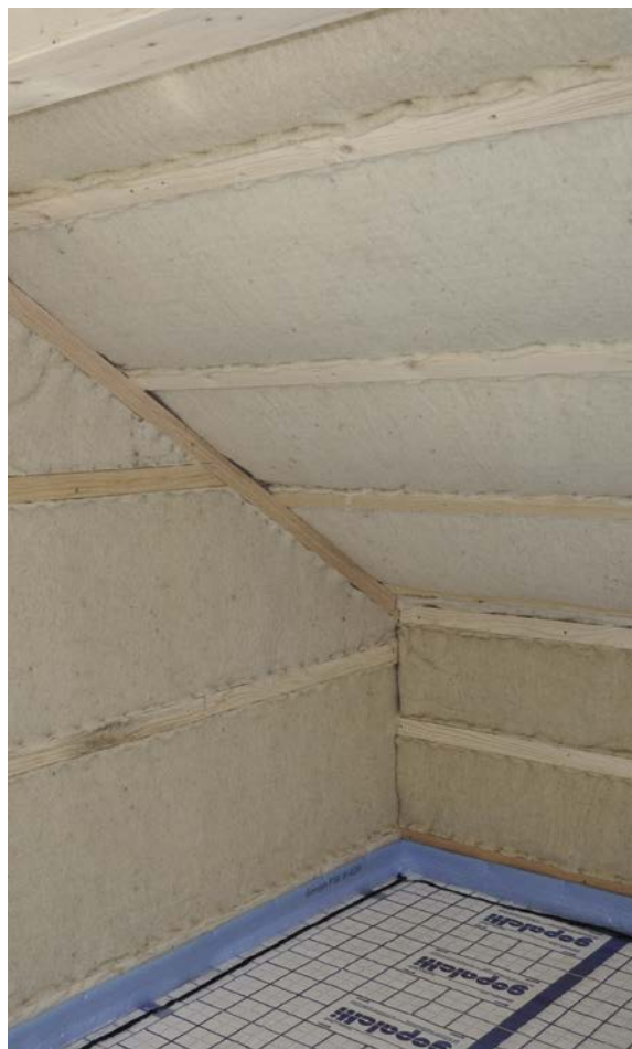
Schafwolle als Deckendämmung oder im Wandaufbau eignet sich für Neubauten und auch für die Gebäudesanierung.
