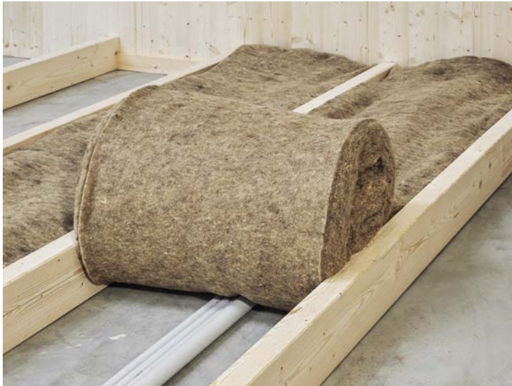
Schnell und leicht zu verarbeiten sind Dämmbahnen aus Schafwolle. Spezielles Werkzeug ist nicht nötig, die Bahnen können geschnitten oder gerissen werden.
